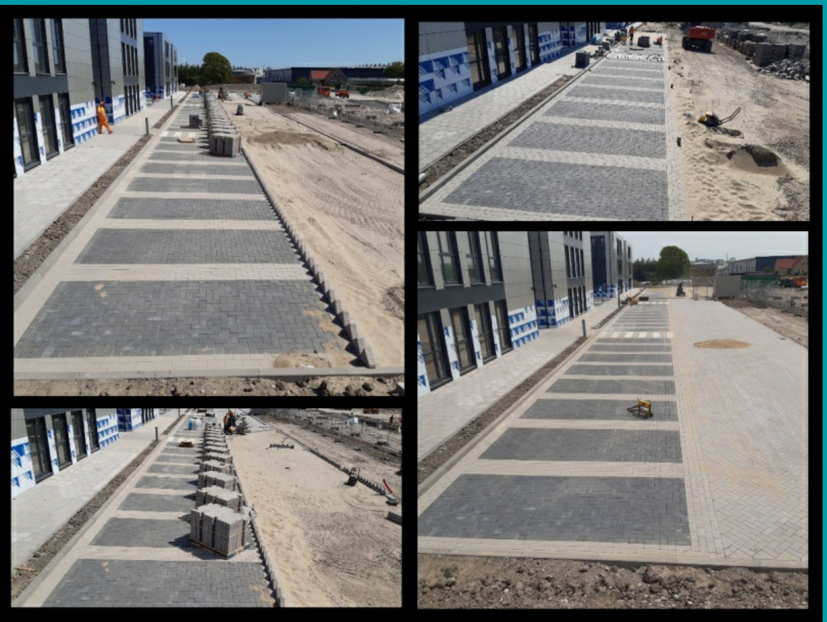
Naaldwijk, aanleggen parkeerplaats bij nieuwbouw
